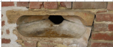
Bouche à feu (tour Sud-Est)
